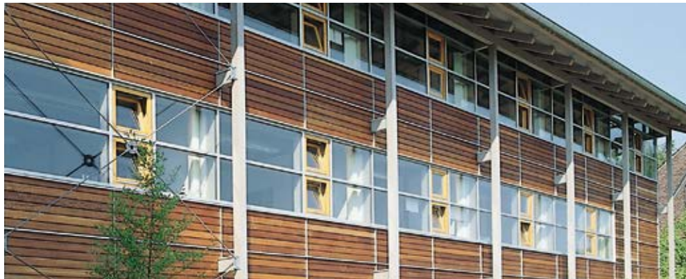
Ingenieurbüro und Verwaltung im Werk Niederkrüchten (Holzbaupreis 2000)
