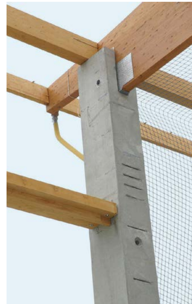
1 Holzstütze 2 Stahlstütze 3 Auflager Betonrähm 4 Stahlbetonstütze
