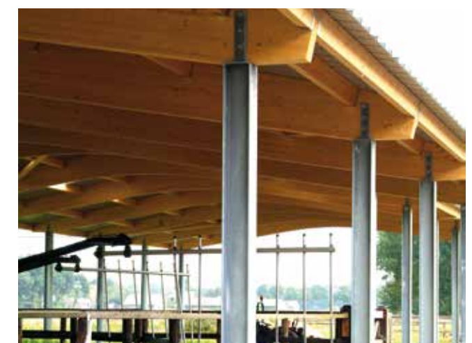
1 Holzstütze 2 Stahlstütze 3 Auflager Betonrähm 4 Stahlbetonstütze
