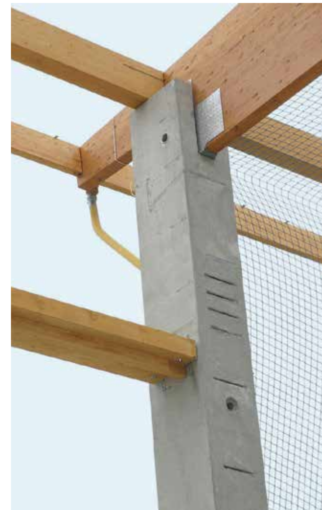
1 Holzstütze 2 Stahlstütze 3 Auflager Betonrähm 4 Stahlbetonstütze
