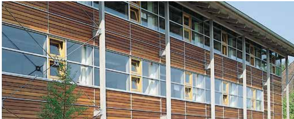
Ingenieurbüro und Verwaltung im Werk Niederkrüchten (Holzbaupreis 2000)
